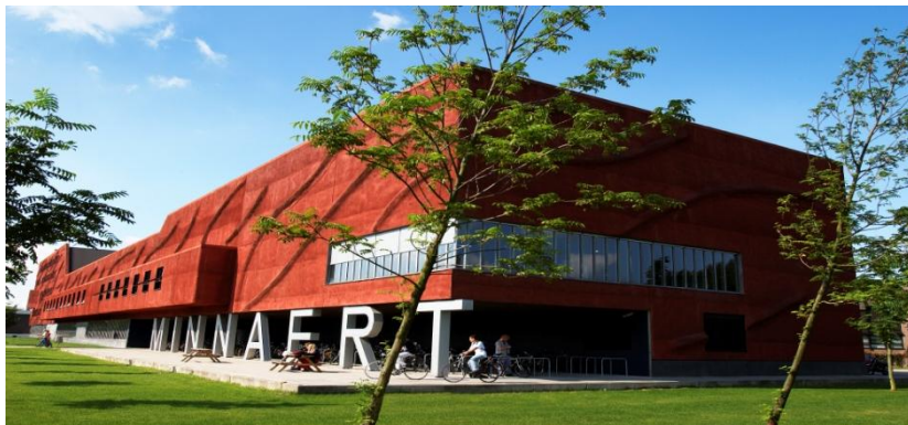
Het Minnaertgebouw is één van de gebouwen van de Faculteit Bètawetenschappen, Universiteit Utrecht.
