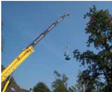
Figuur 8 – Een hijskraan tilt een shovel op.
